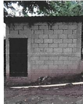
Foto 2: sustitucion de puerta y cambio de cubierta de lamina en cocina ✓
