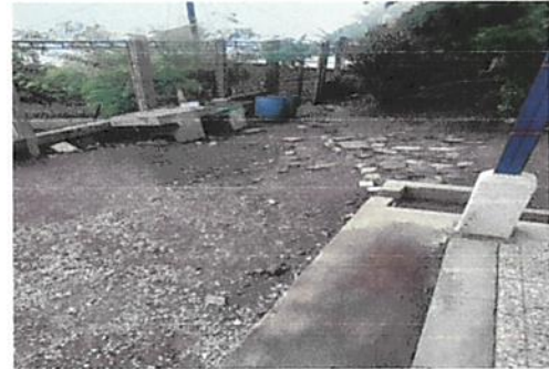
Foto 4: Reparacion de losa de patio con 10 cm de espesor ✓
