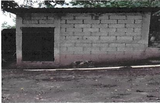
Foto 1: Remozamiento de muro de cocina, repello y cernido de muro en toda la cocina ✓
